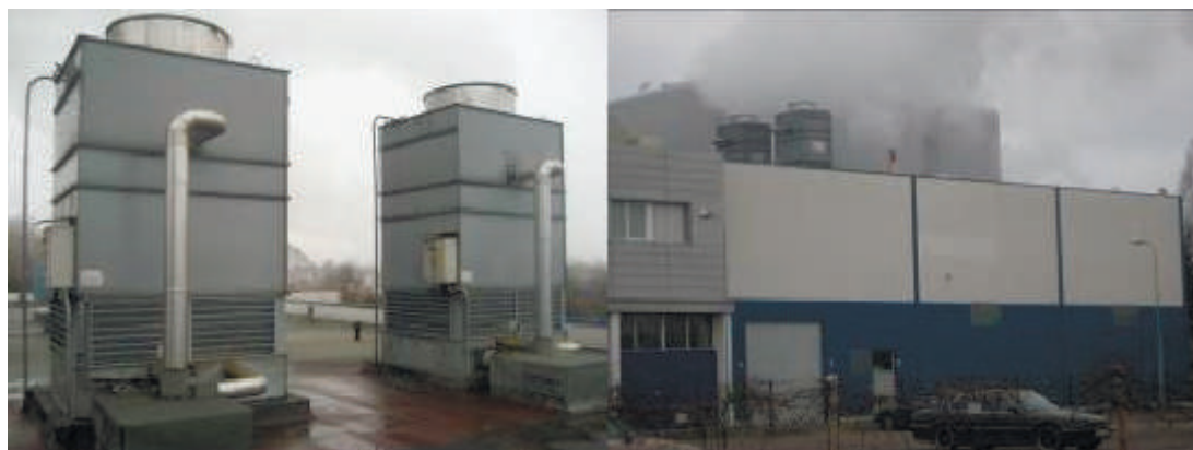
Рис. 37. Градирни открытого типа теплоцентрали "Imanta"
